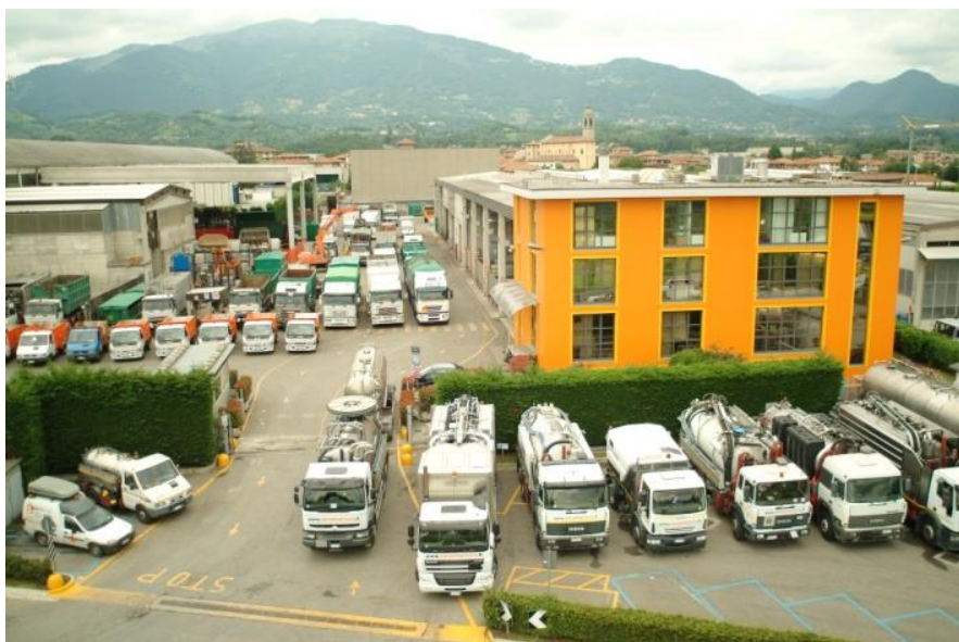
La palazzina uffici cui segue l'area per la messa in riserva e deposito dei rifiuti.
